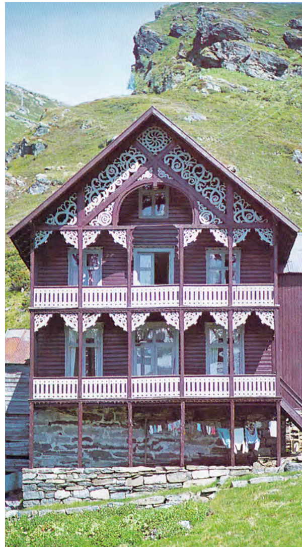
Abb. 67: Touristenhotel in Turtagrø (Luster, Norwegen) im «Sveitserstil», 1888-89, 300 km entfernt in Bergen vorgefertigt (Drange et al. 2003, S. 40)
