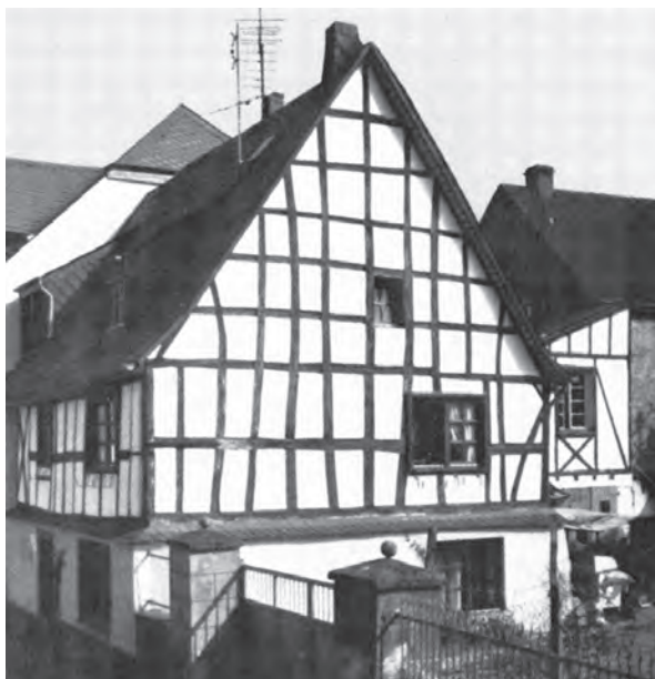
Abb. 22: Kobern Petersstr. 3 (15. Jh) mit natürlich gekrümmten durchlaufenden Ständern im Obergeschoss (Grossmann 2004, S. 113)
