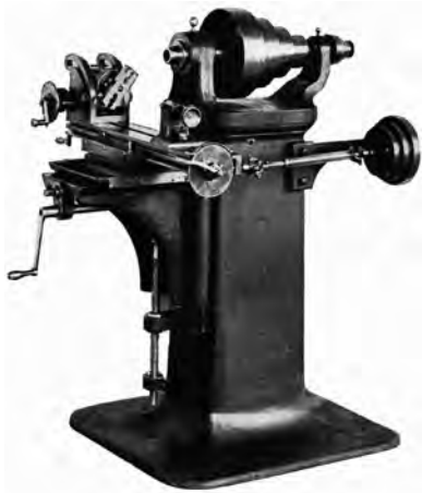
Abb. 101: Erste universelle Fräsmaschine 1862 (Lilley 1966, S. 153, Tafel XXI)
