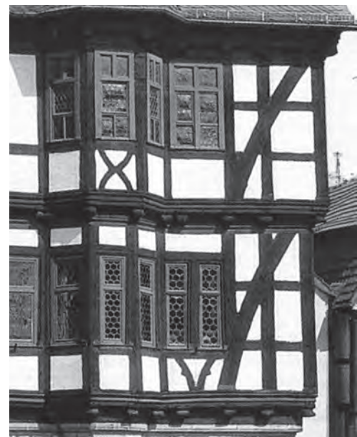
Abb. 23: Detail Alsfelder Rathaus (1512-1516) mit natürlich gekrümmten Langstreben (Gerner 2007, S. 40)
