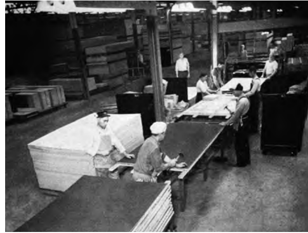
Abb. 97: Montage der Panele (Kelly 1951, Abb. 39/3)
