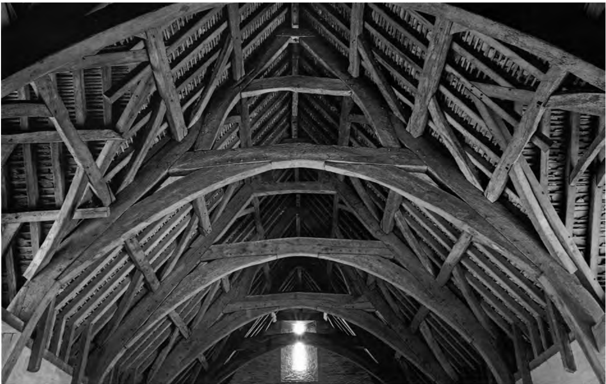
Abb. 25: Krumm gewachsene Konstruktionshölzer im Dachstuhl einer Zehntscheune in Bradford-on-Avon in Wiltshire, 14. Jahrhundert (Kirk 1994, S. 109)
