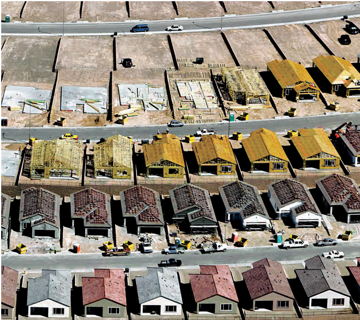
Abb. 90: Platform-Frame 2008 in Henderson, Nevada, 25 km entfernt vom Zentrum von Las Vegas. Gut zu erkennen die vorgefertigten Wandelemente, die erst auf der Baustelle beplankt werden. (Ausschnitt aus MacLean 2008, S. 293)
