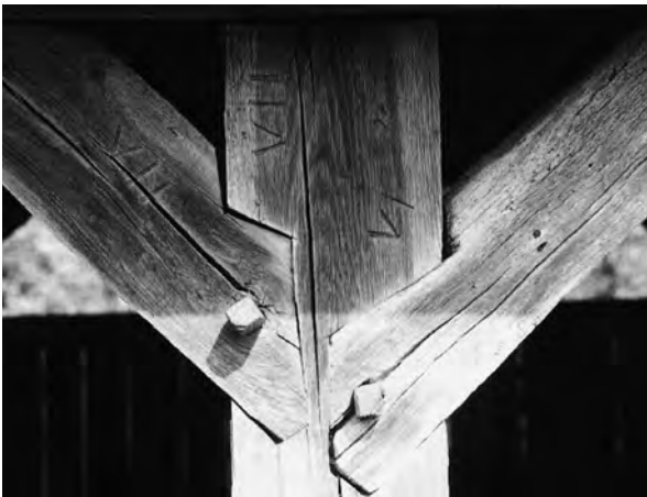
Abb. 37: Schwalbenschwanzquerblatt mit römischen Abbundzeichen, ohne Angaben (Gerner 1992, S. 106)
