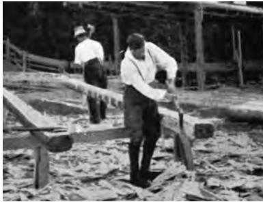
Abb. 26: Planieren ohne Anschlag entlang des Schnurschlags: Zimmerleute im Chiemgau beim Beschlagen mit dem Beschlagbeil (Phleps 1942, S. 13)
