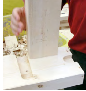
Abb. 120: Schwalbenschwanz-Holzverbindung als Positionierungshilfe in Wandaufbauten und Dachstühlen (Hector Egger Holzbau AG, Langenthal, 2006; Fotos: Autor)
