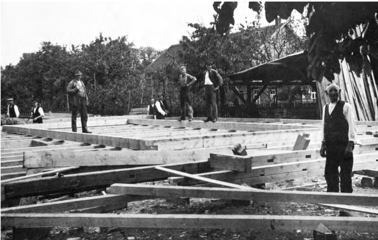
Abb. 34: Zusammenpassbau eines Fachwerks am Abbundplatz, um 1920 (Schadwinkel 1986, S. 229)
