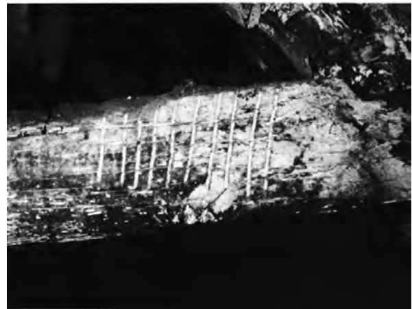
Abb. 36: Abbundzeichen <10> in Strichaddition am Kehlbalken eines Dachwerks von 1404 in Geisslingen, Deutschland (Cramer 1992, S. 29)
