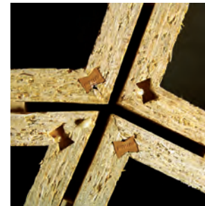
Abb. 121: Detaillierung Swissbau Pavillon der Professur für CAAD, Basel 2005: Hoffmann-Schwalben zur Fixierung des Gehrungswinkels während des Austrocknen des Leims (vgl. Schindler, Scheurer und Walz 2008; Fotos links: Adrian Blain, Fotos rechts: Autor)
