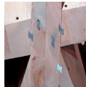
Abb. 122: Detaillierung Libeskind's Futuropolis: Schräg angeschnittene Hoffmann-Schwalben aus Aluminium zur Fixierung der Stösse während des Austrocknen des Leims (vgl. Scheurer, Schindler und Braach 2005; Schindler und Scheurer 2006a; Fotos: Autor)
