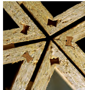
Abb. 121: Detaillierung Swissbau Pavillon der Professur für CAAD, Basel 2005: Hoffmann-Schwalben zur Fixierung des Gehrungswinkels während des Austrocknen des Leims (vgl. Schindler, Scheurer und Walz 2008; Fotos links: Adrian Blain, Fotos rechts: Autor)
