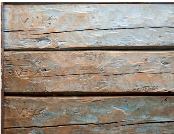
Abb. 39: Römische Abbundzeichen auf einer Blockbauwand eines Pfarrhauses von 1752 aus Leikanger (Sogn), aufgestellt im Norsk Folkemuseum, Oslo (Foto: Autor)
