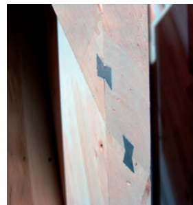
Abb. 122: Detaillierung Libeskind's Futuropolis: Schräg angeschnittene Hoffmann-Schwalben aus Aluminium zur Fixierung der Stösse während des Austrocknen des Leims (vgl. Scheurer, Schindler und Braach 2005; Schindler und Scheurer 2006a; Fotos: Autor)
