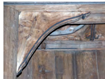
Abb. 21: Holzverbindungen, die die natürliche Wuchsrichtung der Bäume nutzen: Astgabel in Kirk 1994, S. 125; umgekehrte Wurzel als Tragwerksaussteifung einer Stabkirche von ca. 1200, aufgestellt im Norsk Folkemuseum, Oslo (Foto: Autor)
