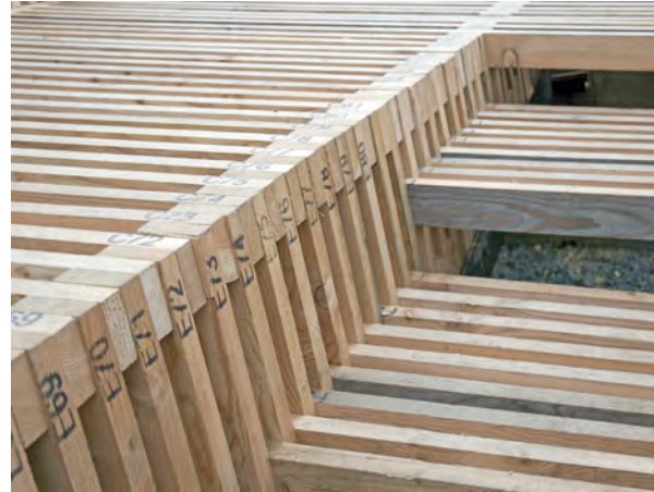
Abb. 108: Eindeutige Bezeichnung der Bauteile mittels Pulldrucker einer Abbundanlage (Foto: Autor)
