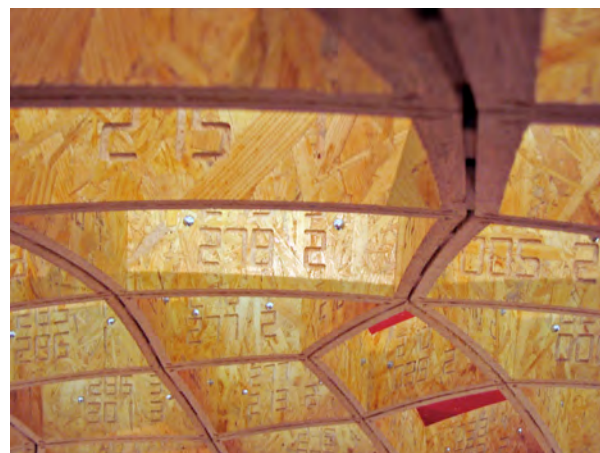
Abb. 112: Bezeichnung der Bauteile mittels eingegräfter Nummerierung (Foto: Fabian Scheurer)
