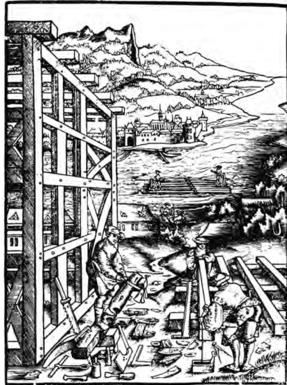
Abb. 33: Zimmerleute beim Abbinden und Aufrichten eines Fachwerkbaus nach Hironimus Rodler. Perspectiva, Frankfurt 1536 (Weiss 1991, S. 89)
