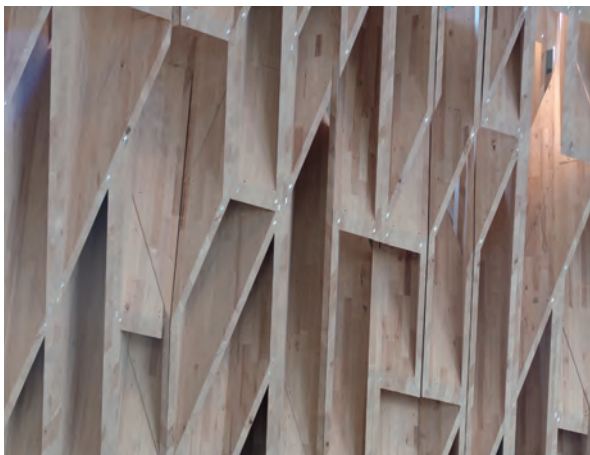
Abb. 122: Detaillierung Libeskind's Futuropolis: Schräg angeschnittene Hoffmann-Schwalben aus Aluminium zur Fixierung der Stösse während des Austrocknen des Leims (vgl. Scheurer, Schindler und Braach 2005; Schindler und Scheurer 2006a; Fotos: Autor)
