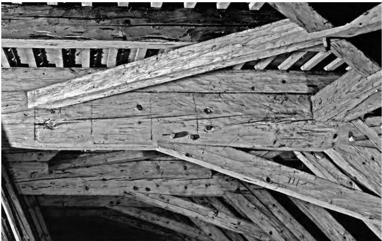
Abb. 31: Klosterkirche Baumburg, 18. Jahrhundert. Bebeilungsspuren an einer liegenden Stuhlsäule im Streiflicht (Holzer und Köck 2008, S. 47)
