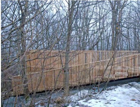
Abb. 107: Ringve Botanical Garden Viewing Platform aus 700 individuellen Elementen, Projekt an der NTNU Trondheim bei Knut Einar Larsen, 2007 (vgl. Larsen, Schindler, Scheurer und Stori 2008; Larsen und Schindler 2009; Foto: Autor)
