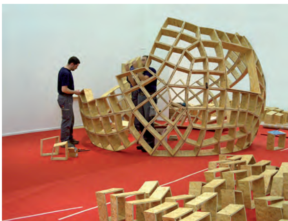
Abb. 111: Swissbau Pavillon der Professur für CAAD, 1280 Einzelteile, Basel 2005 (vgl. Schindler, Scheurer und Walz 2008; Foto: Jürg Gasser)
