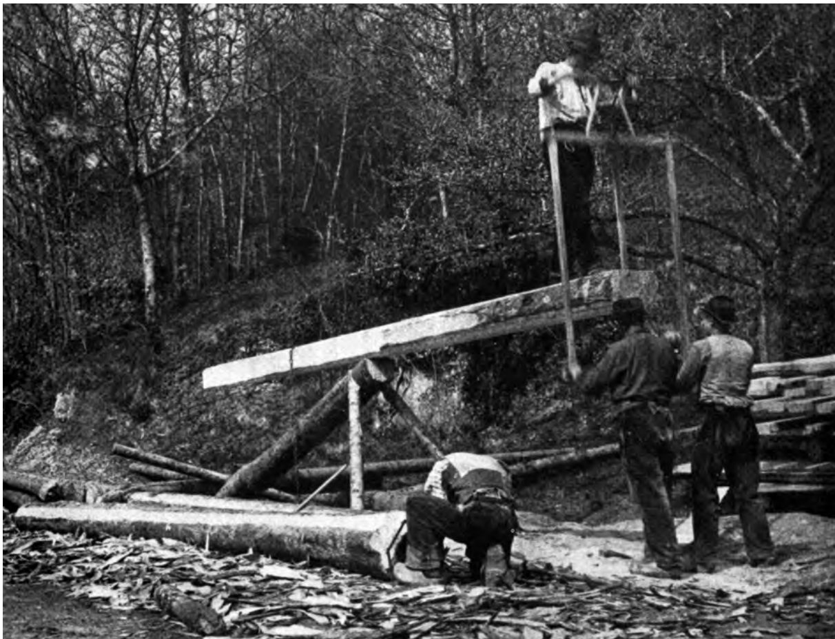
Abb. 29: Auftrennen ohne Anschlag: Schweizerische Zimmerleute um 1900 mit der Klobsäge (Schadwinkel 1986, S. 139)
