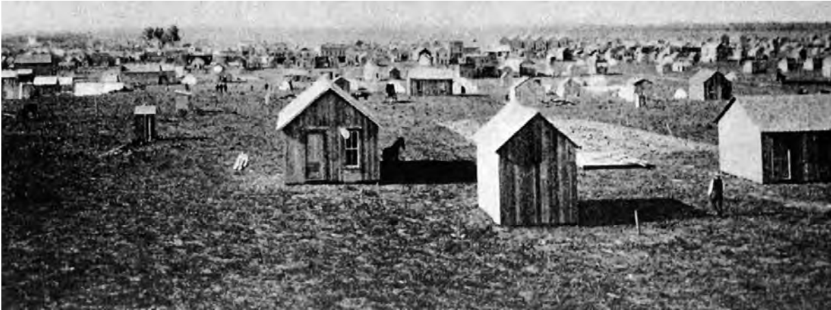
Abb. 89: Balloon Frame 1889, die ersten Präriehäuser für 10.000 Siedler in Oklahoma City vier Wochen nach Stadtgründung (Pfamatter 2005, S. 209)
