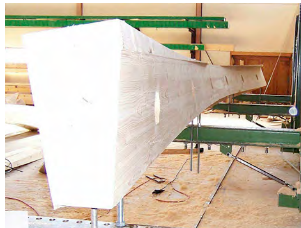
Abb. 127: Prototyp eines Tragwerkselements des Centre Pompidou Metz, Shigeru Ban, 2008 (Foto: Holzbau Amann, Martin Pfundt)
