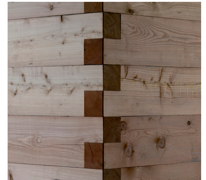
oben: Sitzprobe an der Aufrichte, Juni 2013 links: Explosionszeichnung der Konstruktion unten: Eckdetail im Appenzeller Strickbau
